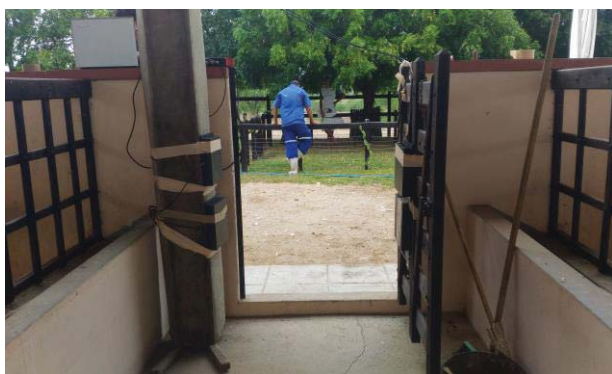
Figura. 2: Antenas posicionadas para testes.
